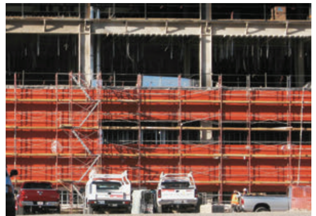
Veteran's Administration Main Hospital, North Las Vegas, NV 37,161 m 2 de WrapShield SA Autoadhésif avec revêtement extérieur de brique et de métal Trespa.
